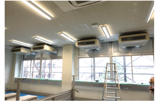
換気設備工事
